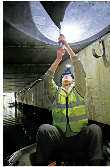
技术人员深入桥底对桥梁进行检测。(余建文 应健 摄)
