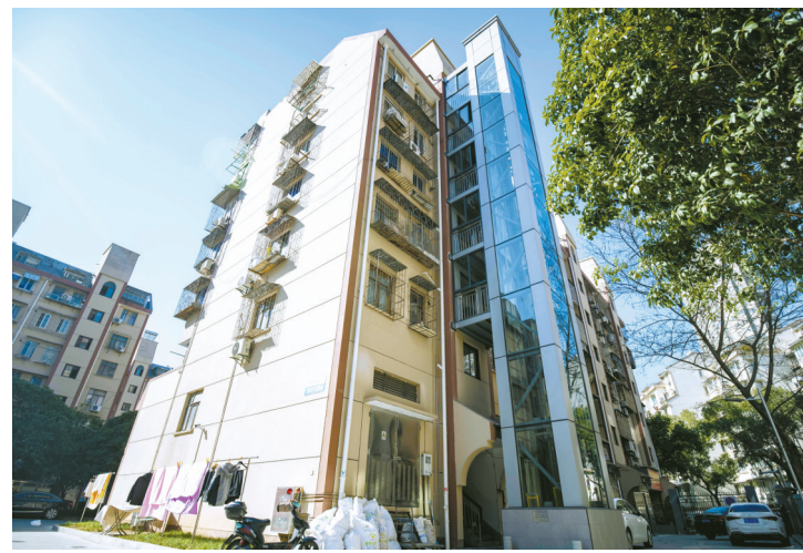
图为新加装的电梯。
