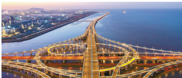
杭甬复线宁波段一期昨日通车,交通路网改造再提升。
