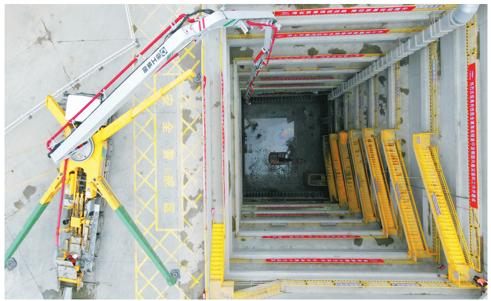
历时8个月，项目团队成功打造“内实外美、不渗不漏”的盾构工作井。(中铁十四局供图)
