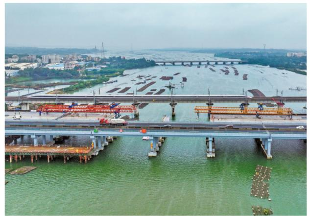
沈海国家高速茂湛段改扩建石门大桥新桥已经建成通车,目前正在拆除旧桥(无人机照片,1月23日摄)。
