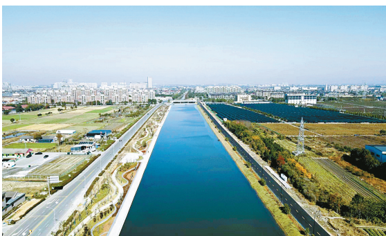
余姚北排二通道
