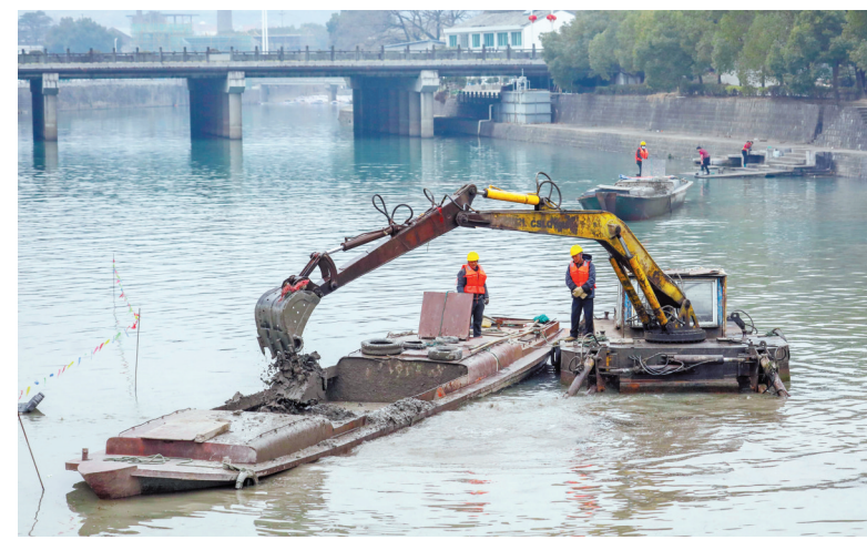
南塘河鄞江段河道清理疏浚工程现场。
