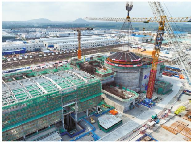
2月6日，海南昌江核电厂多用途模块化小型堆科技示范工程“玲龙一号”外穹顶在进行吊装作业（无人机照片）。
