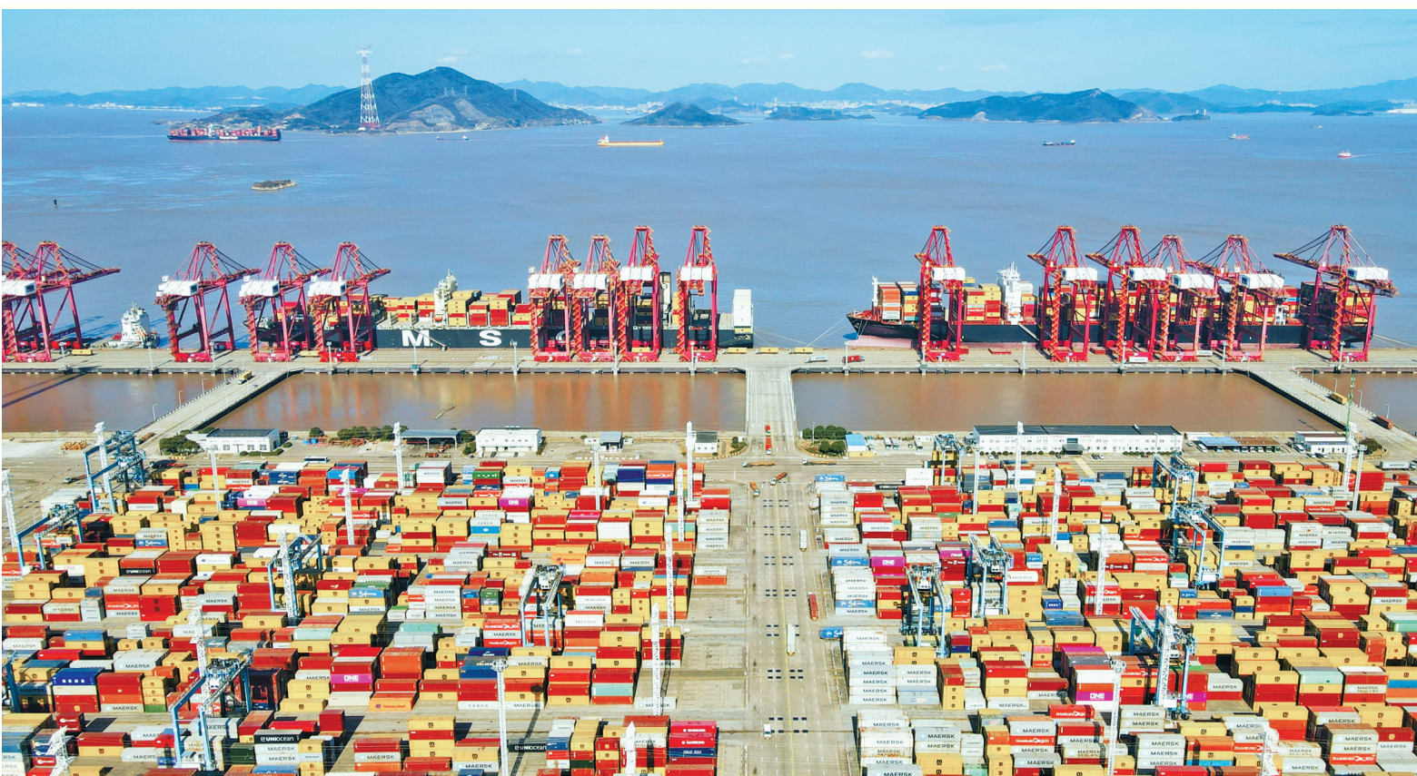
宁波舟山港穿山港区集装箱码头作业现场。
