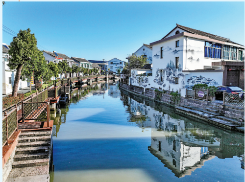
咸祥河西宅村段的河岸慢行道。
