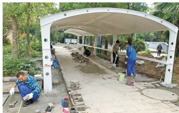
非机动车车棚在建设中。
