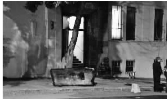
1月2日凌晨，中国驻旧金山总领馆损毁的大门被拆卸后放在地上。新华社发
