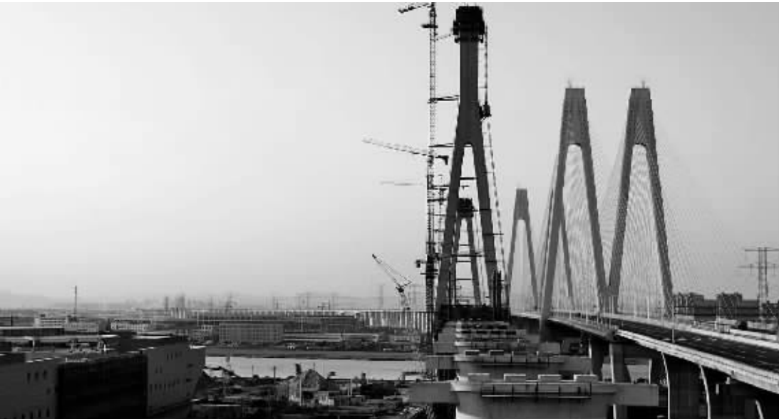
5日下午，塔高177.91米的铁路甬江特大桥南索塔主塔顺利封顶。铁路甬江特大桥是我市铁路北环线的重点控制性工程，也是我国首座特大跨度铁路钢混合梁斜拉桥，大桥主跨468米，一跨过甬江，预计在5月底大桥贯通，今年年底北环线洪塘经甬江主桥至宝幢区间有望提前开通。
