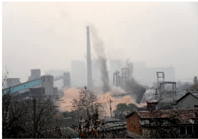
武汉打响雾霾整治“第一炮”。8日，武钢集团江南燃气热力公司的标志性建筑——焦炉烟囱被爆破拆除。
