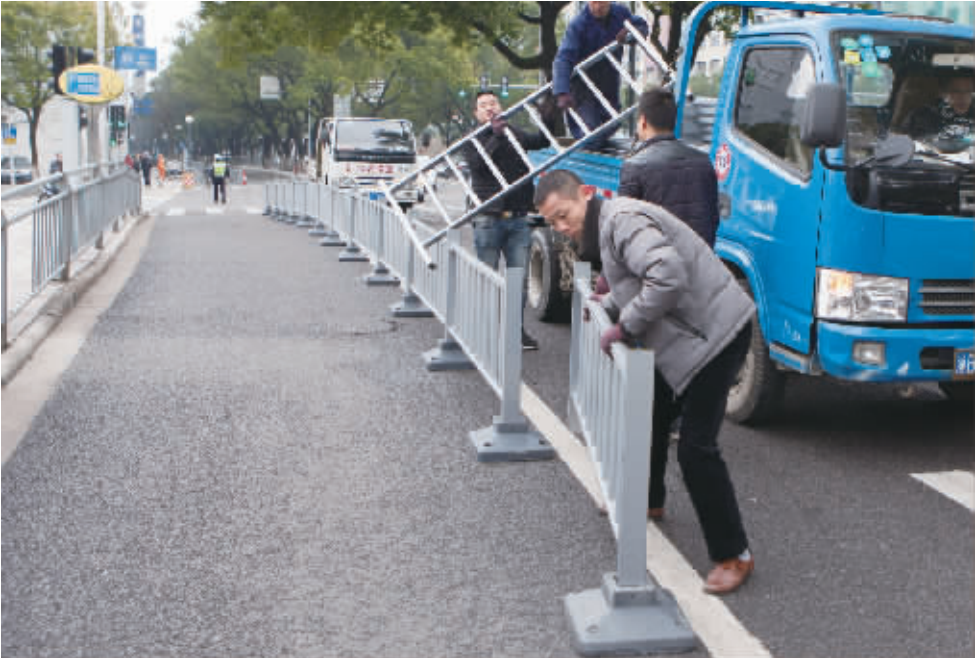
2月8日，长春路上施工人员正在加装隔离栏。 记者 唐严 摄
