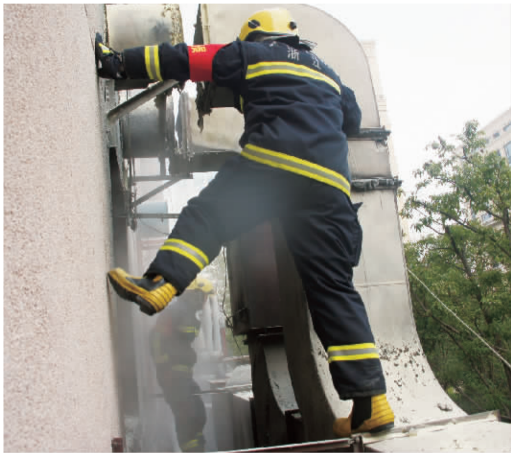
2月22日，江东甬港饭店，消防人员在检查油烟管道。最近连续发生的餐厅厨房火灾都是由于油烟管道内的积垢被火星溅燃所致。 记者 马涛 摄
