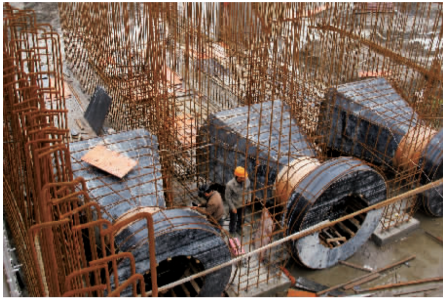
工人正在现场施工。边城雨 摄
