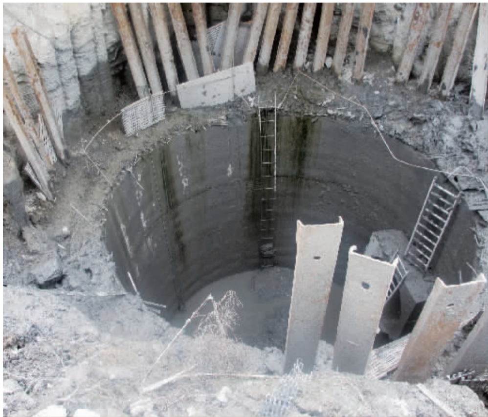
用来偷排泥浆的深井。
