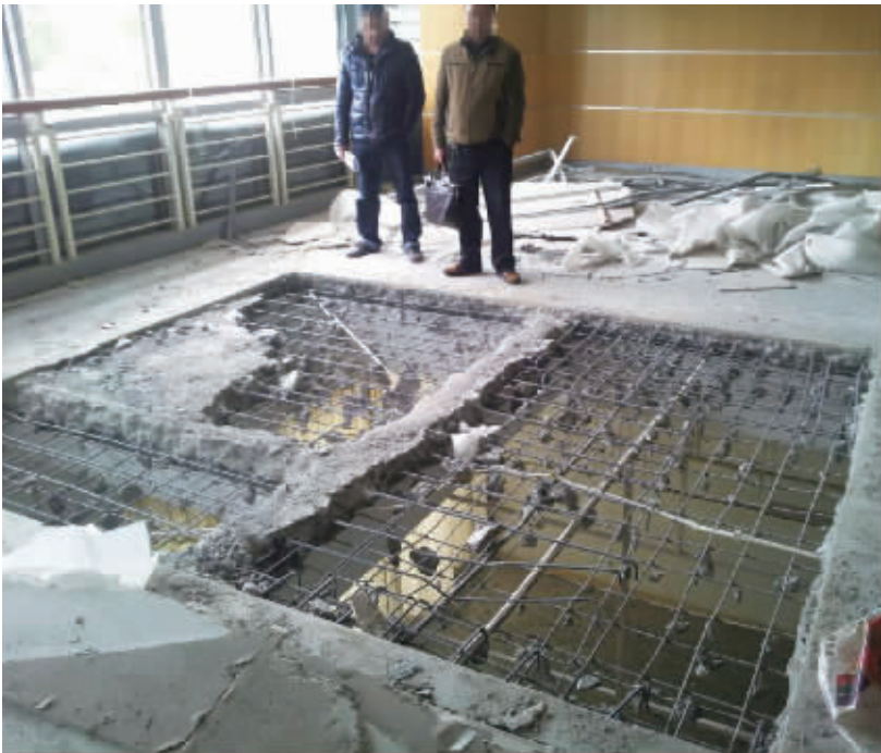
拆穿楼板搞装修现场。
