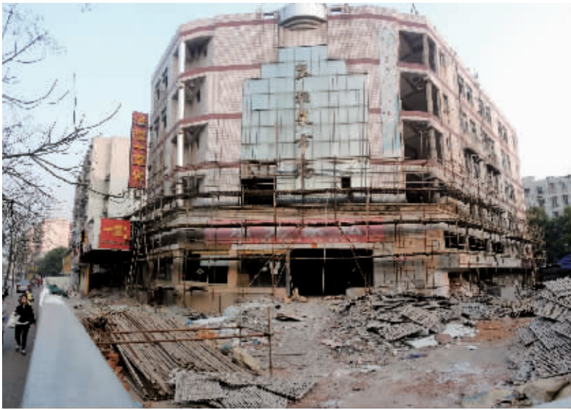
原菜市场西北侧，正在改造中的翠柏菜市场外墙仍搭着脚手架。
