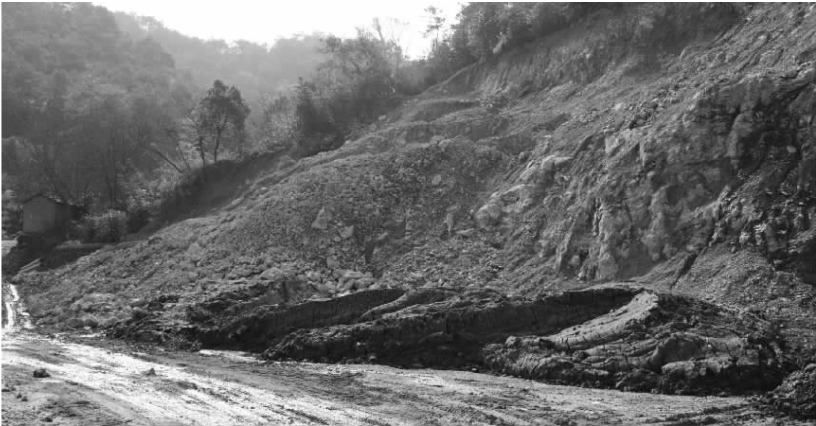
黄土山靠山道的一侧已被挖空。
