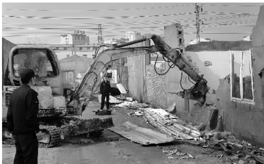
伴随着挖掘机的轰鸣声，违法建筑被一一拆除。 龚国荣 摄
