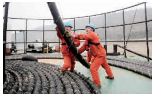
工人在敷设海底电缆。 通讯员 王幕宾 摄
