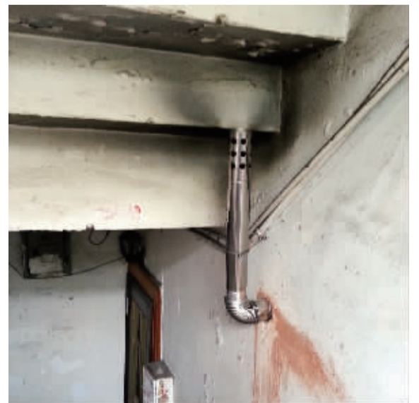
直通楼道的燃气热水器烟道。
