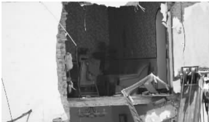
坍塌居民楼的局部。 通讯员 高俊达 摄
