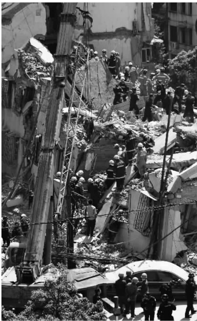
搜救人员在塌楼现场展开救援。 通讯员 高俊达 摄
