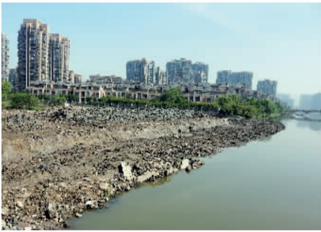
图为填河现场。
