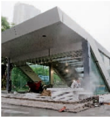
地铁1号线鼓楼站出入口露出雏形。记者 唐严 摄
