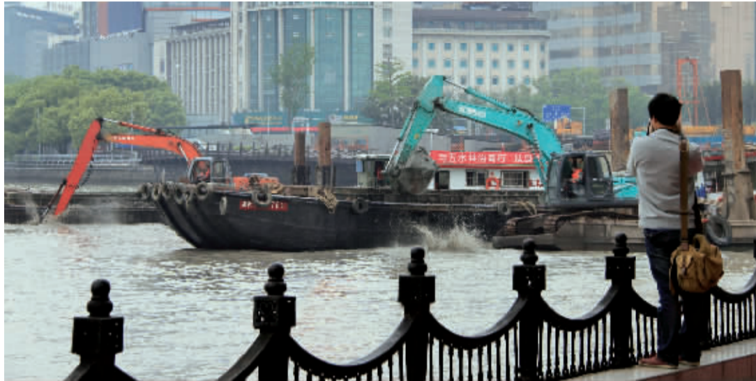
昨天上午，两艘施工船正在对老外滩江段进行清淤疏浚。 记者 龚国荣 摄
