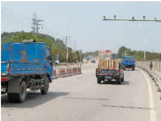
“非现场治超”系统在运行。
