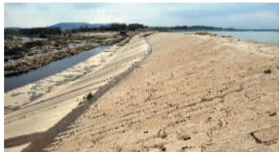
雄伟的石结构戴村坝。 周建平 摄
