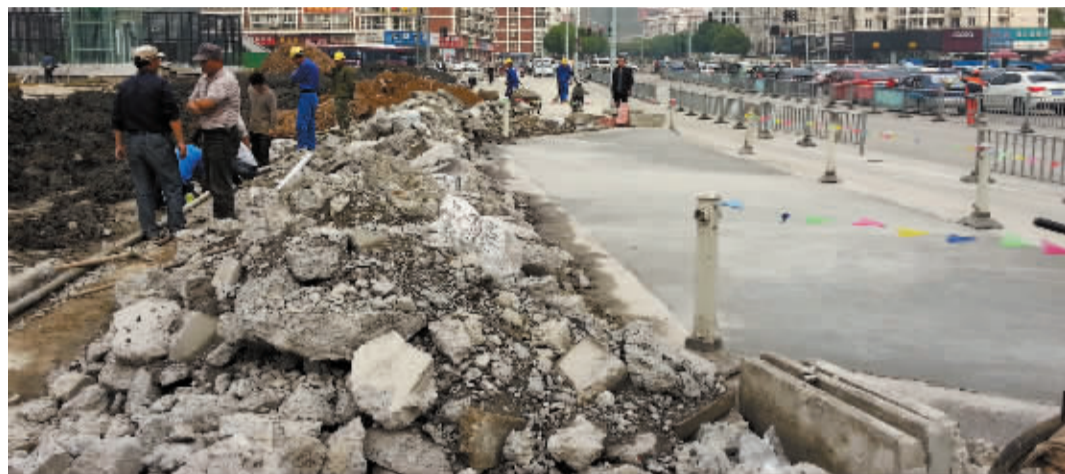
被挖开的水泥路。
