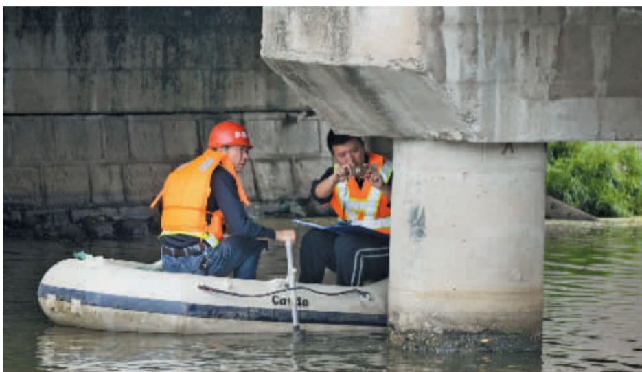
工作人员正在检测桥梁。
