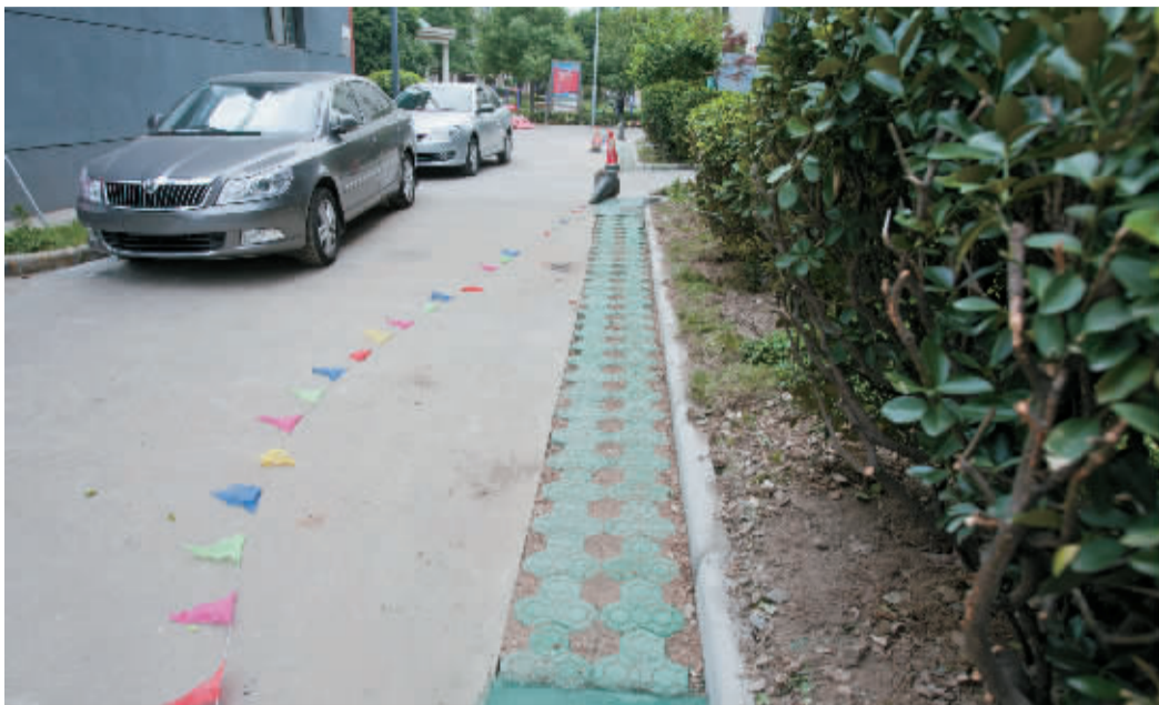
小区内部分道路的绿化带被铺上了草坪砖，以增加道路通行能力。 记者 唐严 摄
