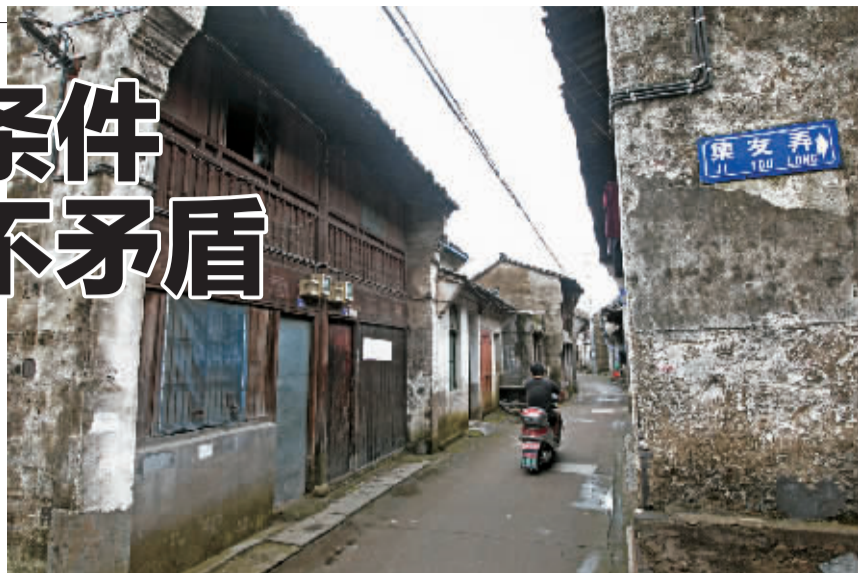
丈亭老街沿河民居
