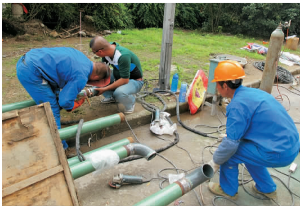
海曙朝阳新村内,施工人员正在更换破损的地下管网。
