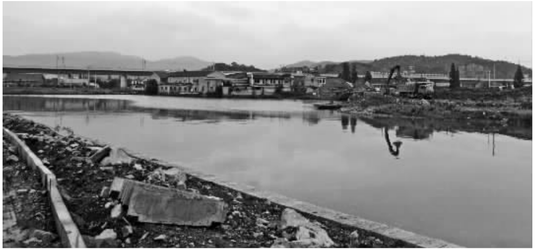
慈江、刹子港交汇处及远处的夹田桥。
