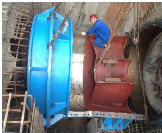
铜盆浦泵站工人正在装水泵。 边城雨 摄
