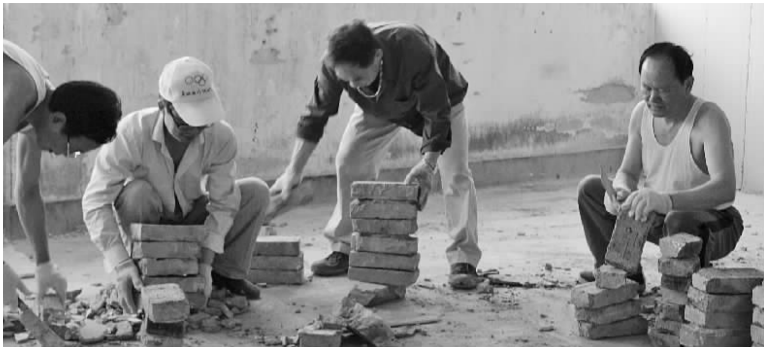
社区党员志愿者正在整理工地里捡来的砖头。
