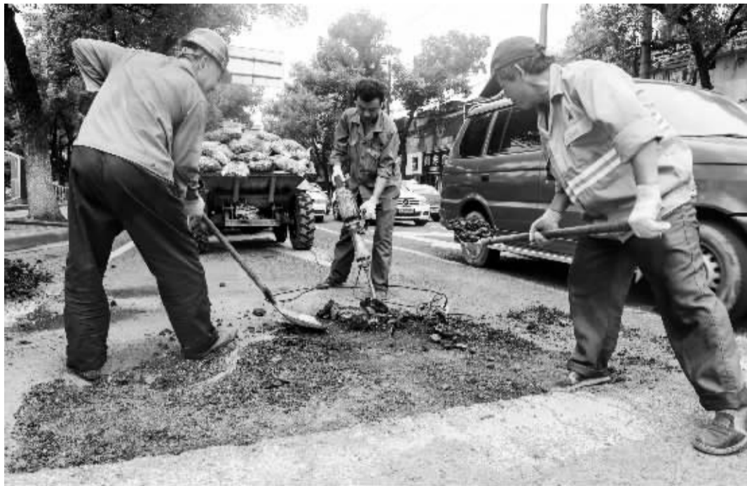
昨天,工人们在曙光路修补坑洞。记者 徐佳伟 摄
