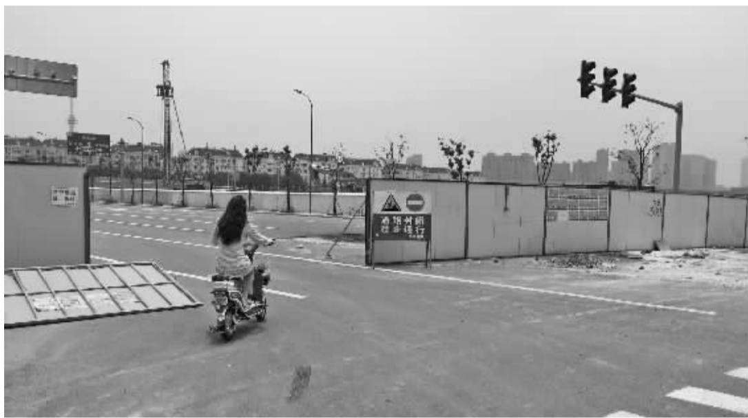
被封闭的建兴西路。
