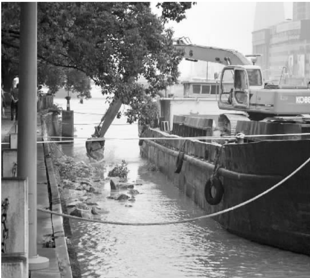
前天上午,工人正从船上往奉化江江边堆石块作为护坡。 记者 唐严 摄
