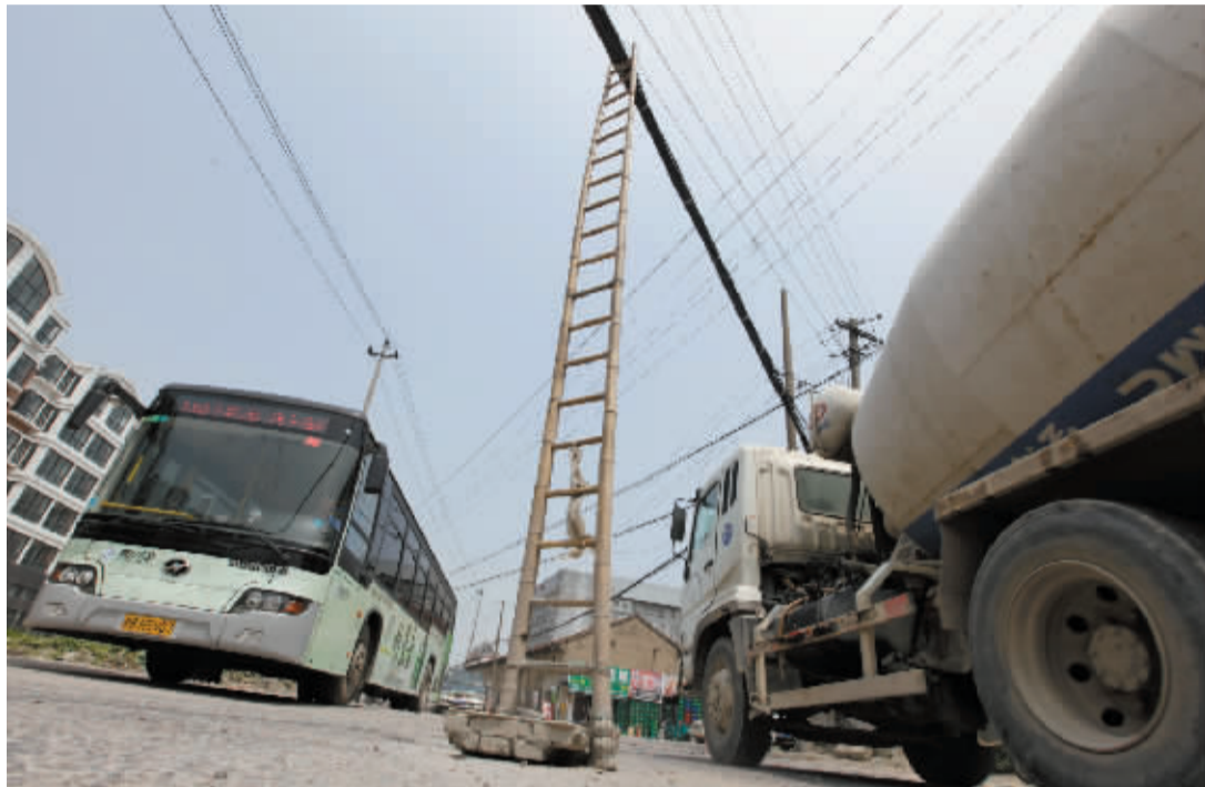
5米高竹梯顶着线缆立在鄞州区云林东路中央。
