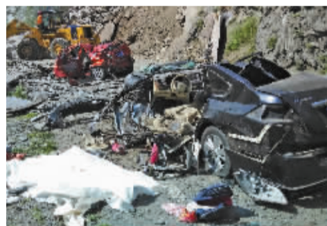
7月17日,救援人员在塌方现场施救。
