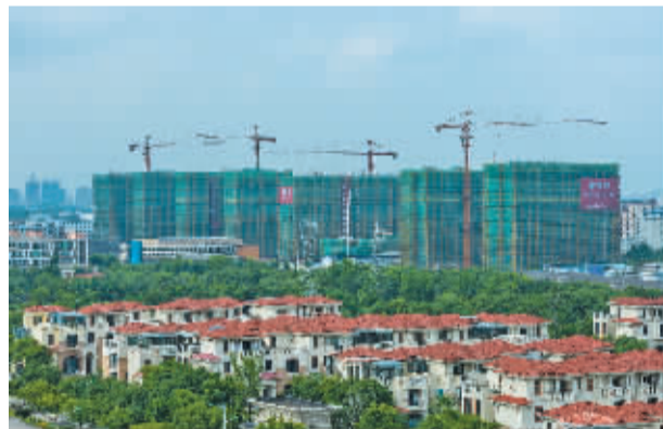
在建的橄榄树小区。徐佳伟 蒋雪莹/摄
