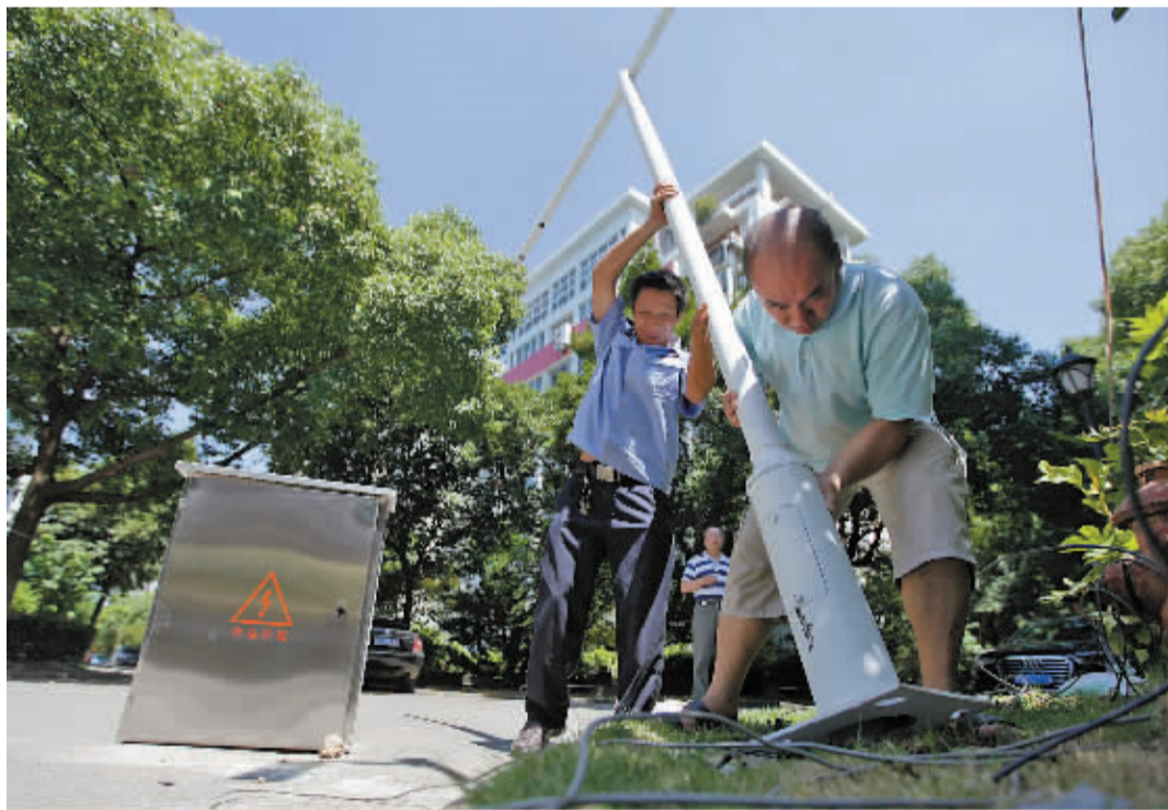
天一家园正在安装新探头。 记者 许天长 摄
