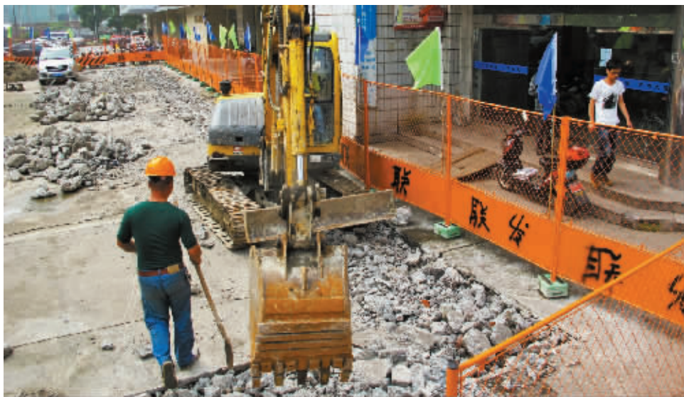
正在进行的朝阳新村改造工程。
