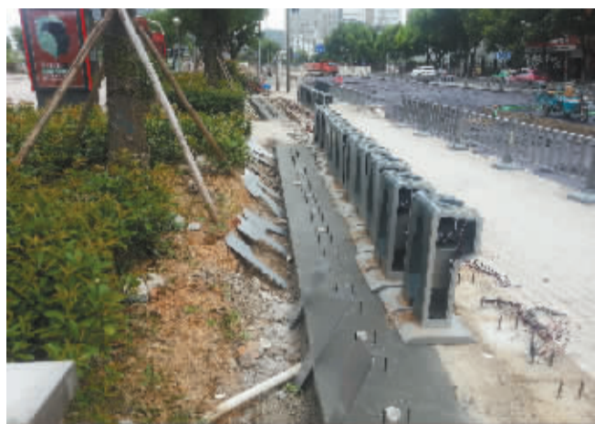
正在被拆掉重建的公共自行车桩位。 记者 黄金 摄
