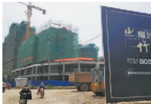
旗杆庄旧城改造片区正在修建商品房。
