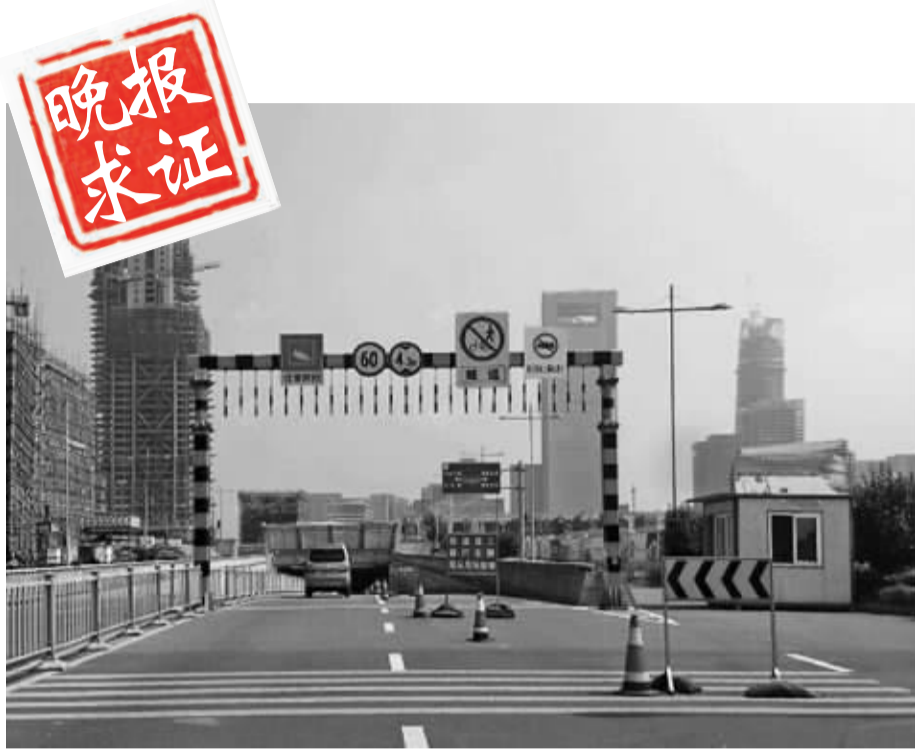
处于半封道状态的江澄路隧道。网友“永泳甬涌”供图
