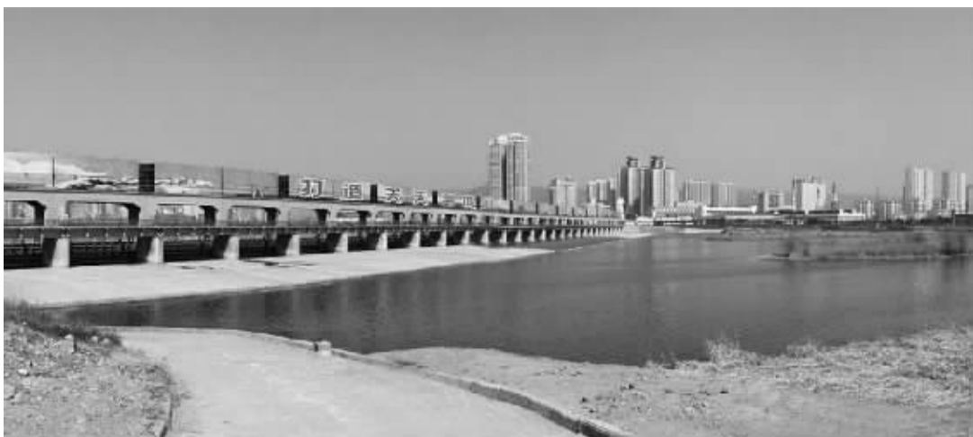
宝鸡市拦渭河建造的金渭湖因干旱水域缩小一半。
